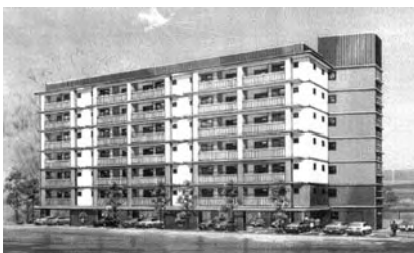
PFIによる県営住宅の建設（山形市本町）
